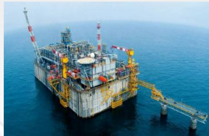
Off shore su piattaforma – Porto Viro (RO)
